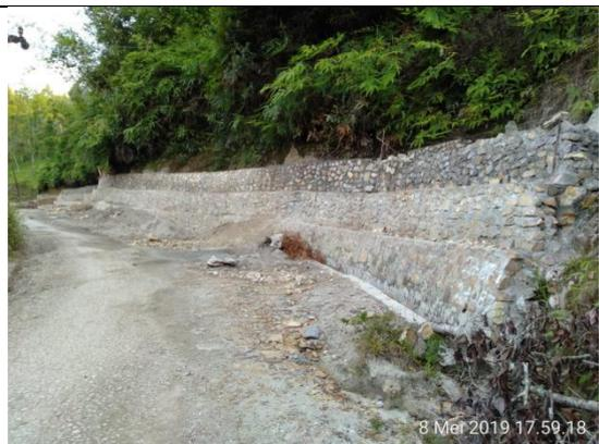
Penguatan dinding tebing (DPT, *retaining wall*) di jalan akses yang bersinggungan dengan jalan umum warga setempat agar tidak longsor
